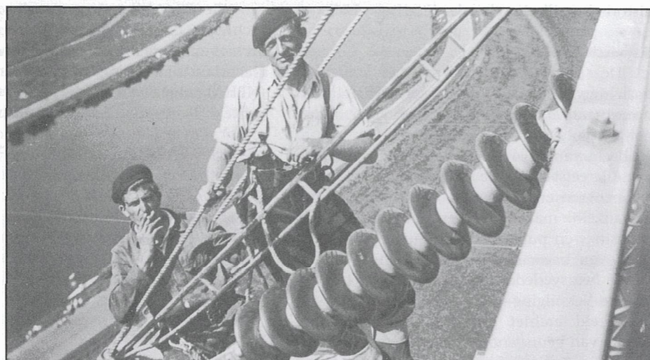
In 1952 startte de bouw van het koppelnet 150 kv tussen Amsterdam-Utrecht [Inv.nr. BN 1952].
